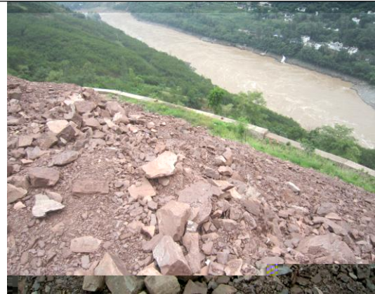
弃 场 拦 挡 措 施
